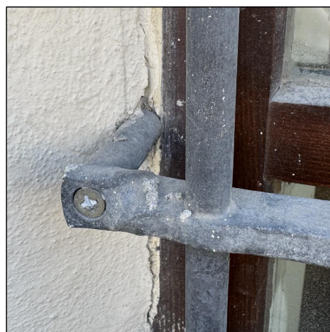
Kotvení mříže do rámu okna
